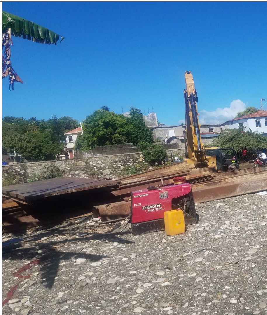
Les firmes commencent par installer les matériels nécessaires aux travaux
