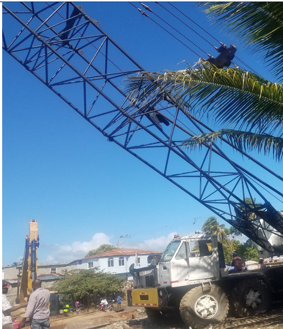
Une vue des matériels installés sur l'un des sites du projet
